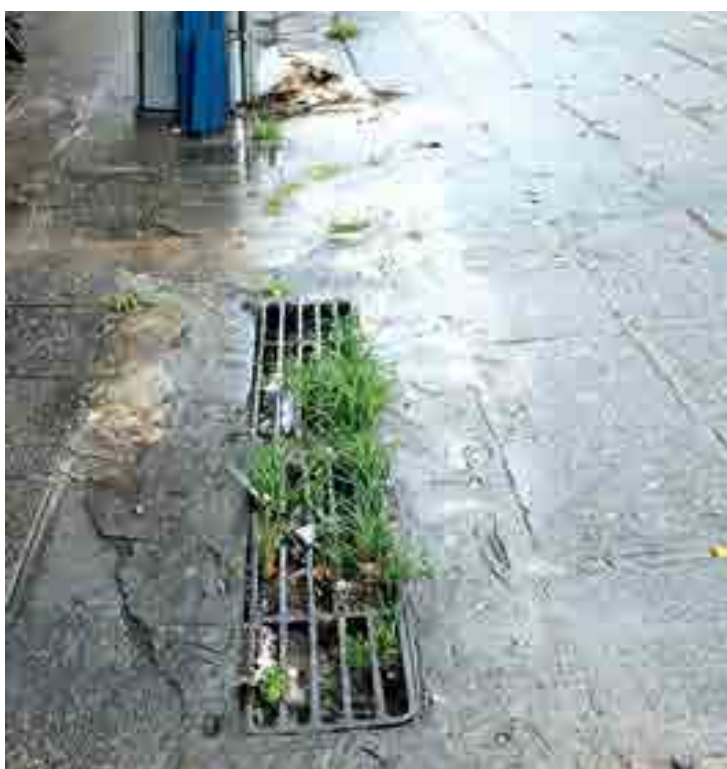
Na calçada do Centro, as galerias estão cheias de lixo, areia e até mato
