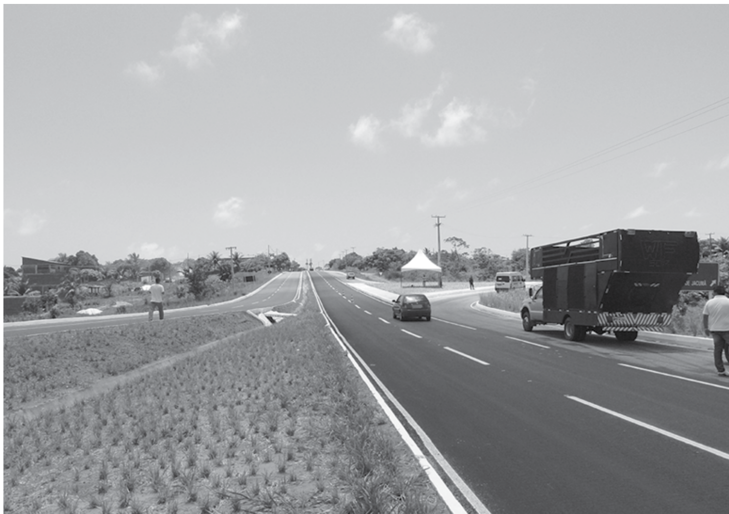
Contorno de Jacumã, que levou mais comodidade a moradores e turistas do município de Conde, está entre as obras concluídas e já inauguradas
