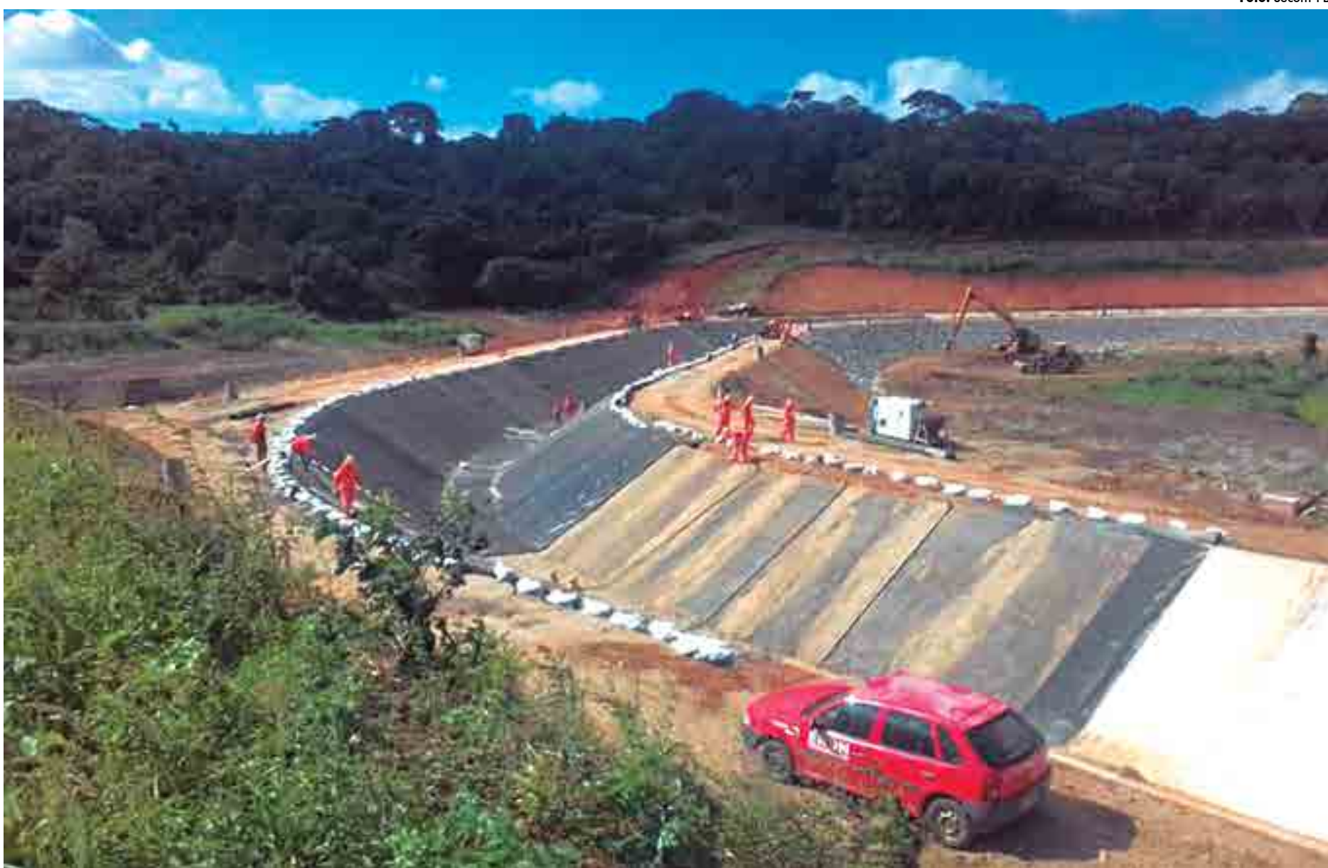
Paraíba investiu cerca de R$ 1,2 bilhão para interligação das bacias, com a construção de aproximadamente 1.500 km de adutoras, garantindo a segurança hídrica da população
