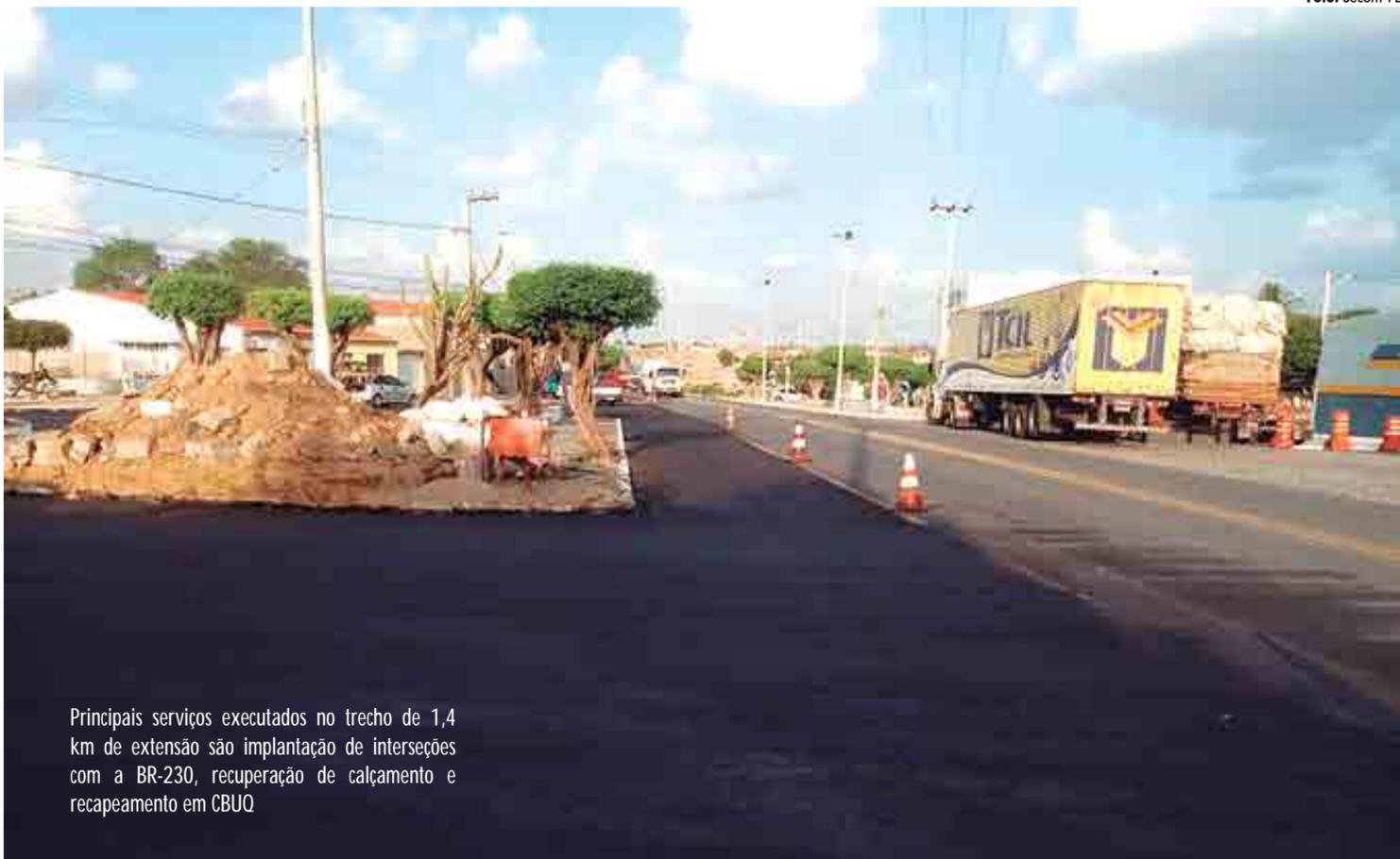
Principais serviços executados no trecho de 1,4 km de extensão são implantação de interseções com a BR-230, recuperação de calçamento e recapeamento em CBUQ
