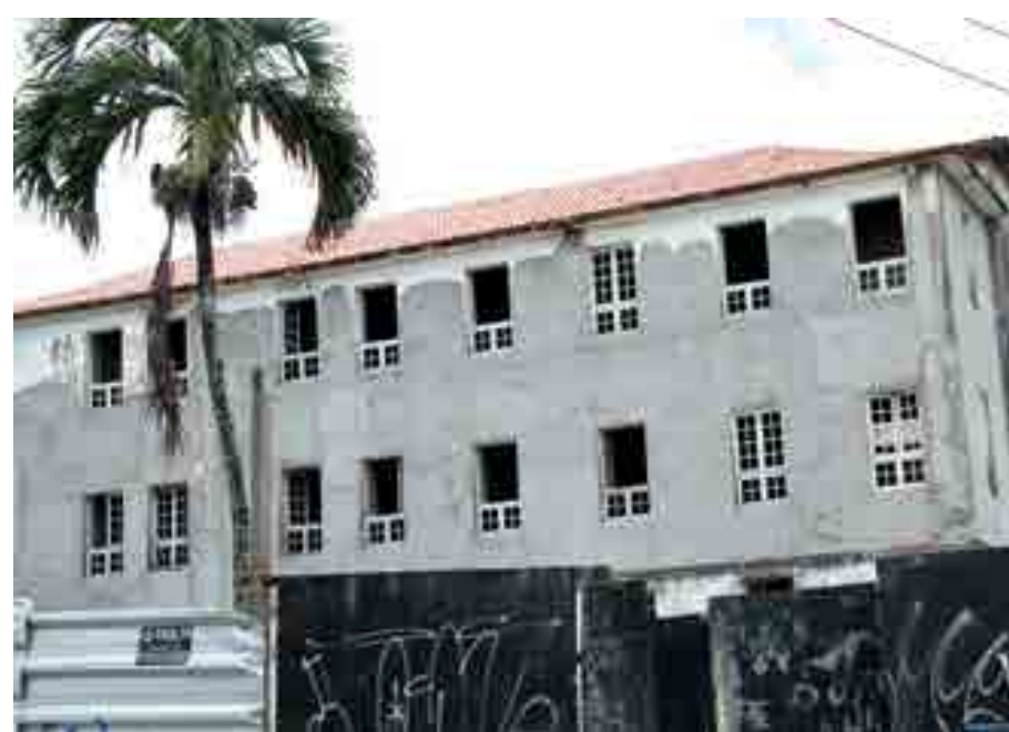
Apesar da estrutura totalmente coberta e paredes revestidas ainda falta muito para a conclusão
