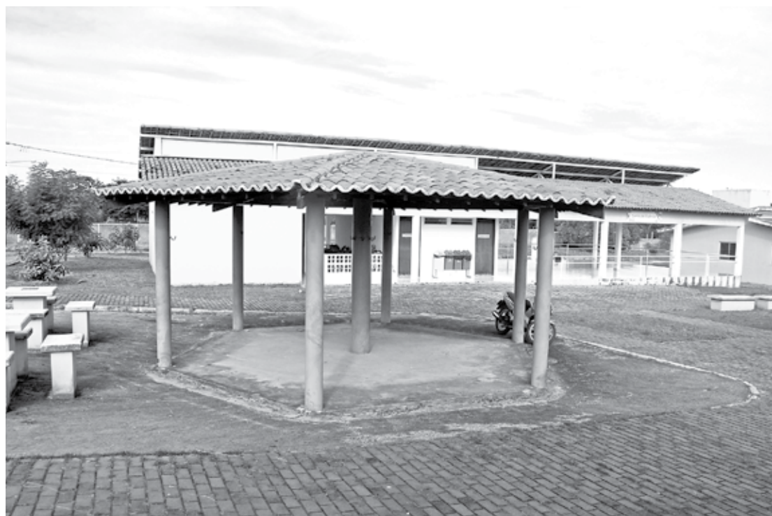
Cada edificação foi projetada de acordo com as normas de acessibilidade para o público que habita o Cidade Madura
