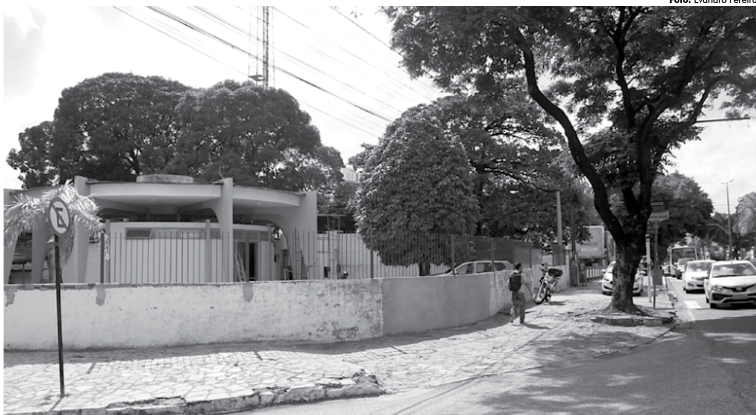
O prédio onde funcionava a 3ª Distrital foi escolhido por conta da localização privilegiada, garantindo acesso com agilidade a vários pontos da cidade
