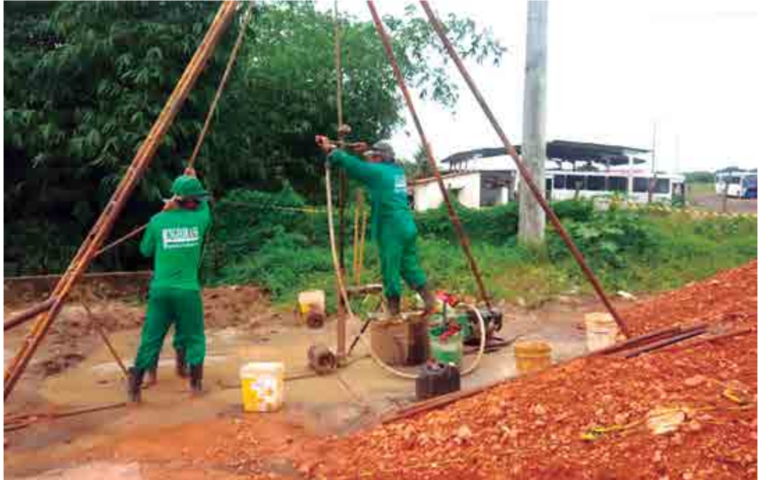
Os técnicos orientaram operários nos trabalhos de sondagem do solo na rodovia PB-004, onde será construída a nova ponte ligando Santa Rita a Cruz do Espírito Santo e Sapé
