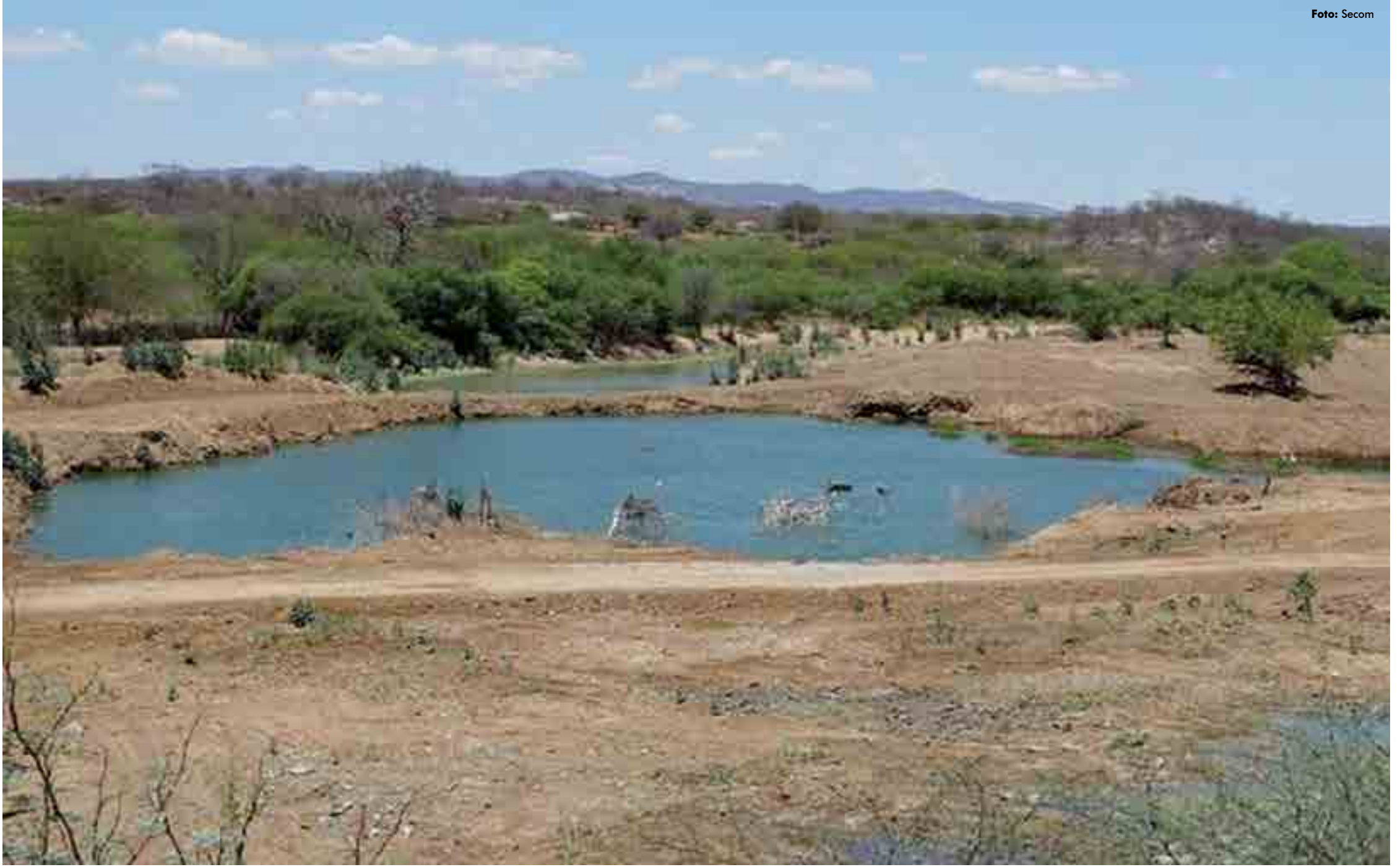
Orientação para liberação das águas do São Francisco para o canal da transposição em Monteiro foi feita após monitoramento da barragem de Cacimba Nova, no município de Custódia, em Pernambuco, no eixo leste
