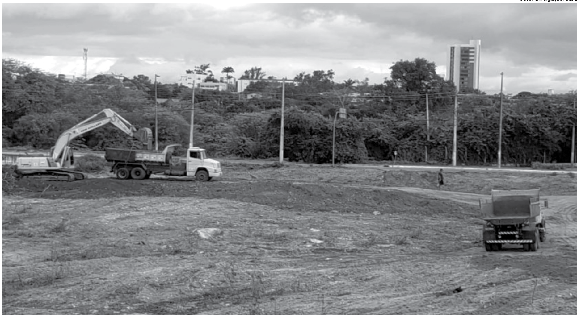
Em Campina Grande, os serviços de terraplanagem do terreno onde será construído o FabLab foram iniciados no último dia 15 de julho e estão sendo custeados pelo Governo do Estado
