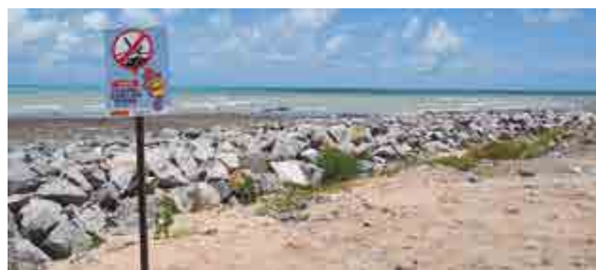
Pedras estão posicionadas ao longo da base da barreira para reduzir a erosão causada pelo avanço do mar
