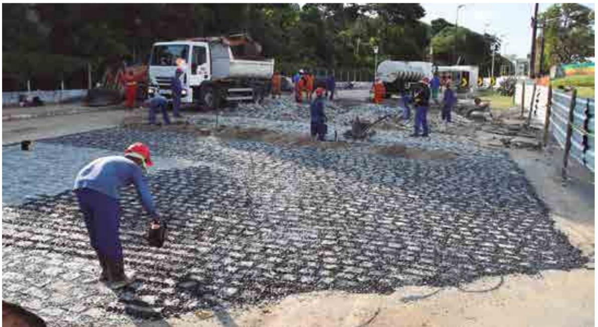
Trecho será liberado com pavimentação em paralelepípedos para que a passagem dos veículos faça a compactação do solo; o asfalto será colocado numa segunda etapa
