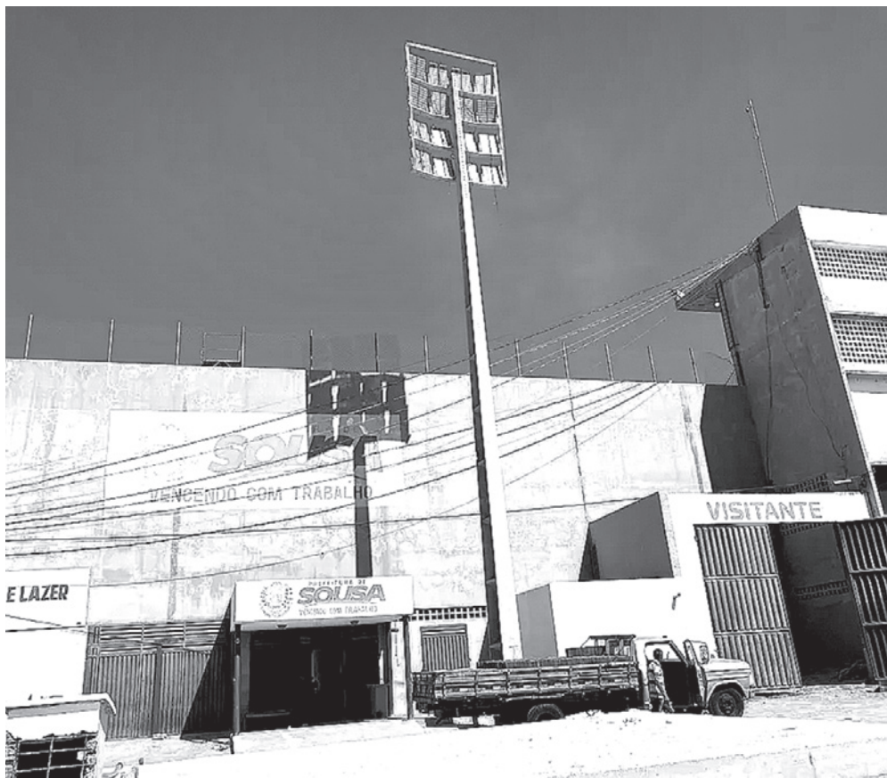
O novo sistema de iluminação led do Estádio Marizão está em fase de conclusão
