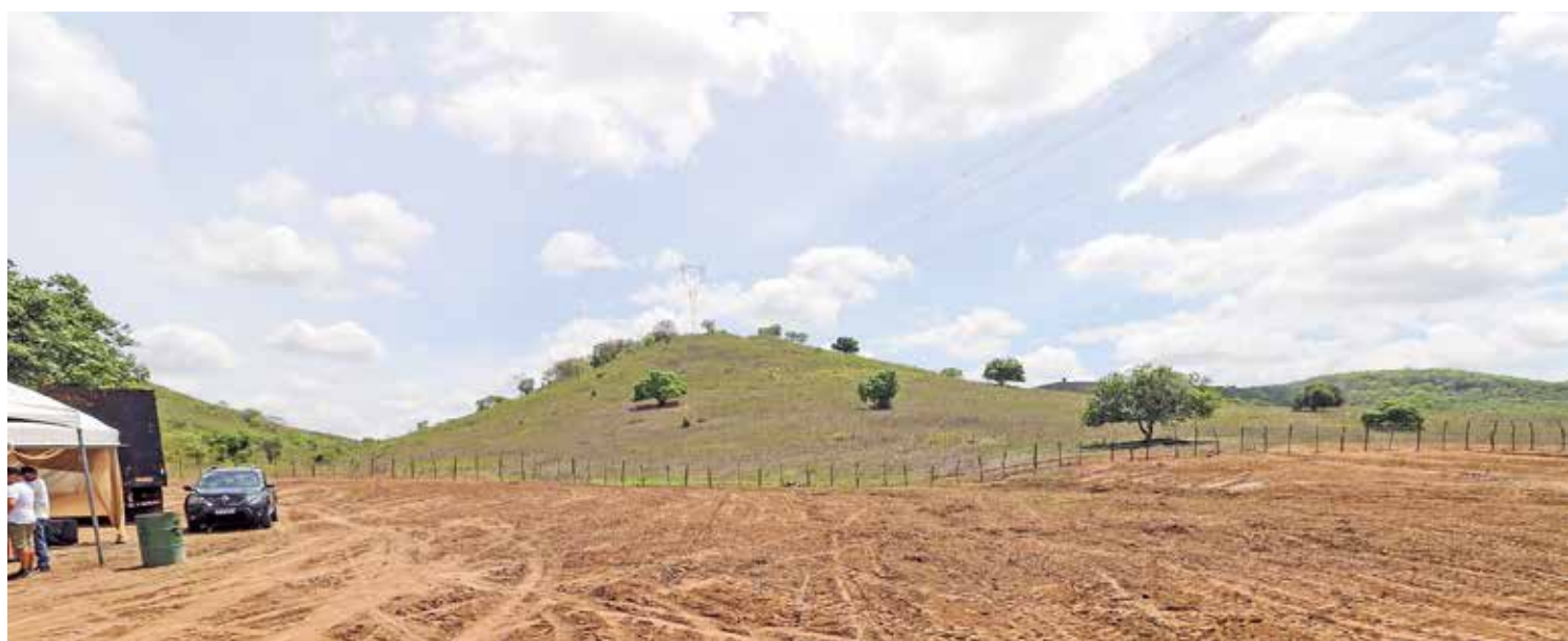
O local para construção do abatedouro já está disponível para início da obra, que terá 232 m 2 e será erguida com premoldado
