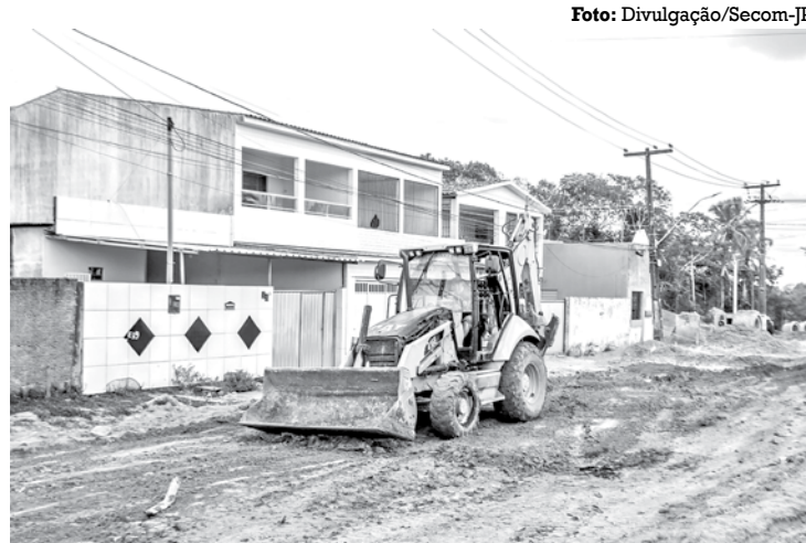
Obras de drenagem e pavimentação são realizadas em bairros de JP
