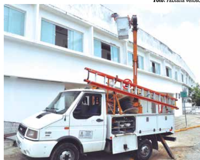
Equipe da PMCG restaurou o fornecimento de energia elétrica
