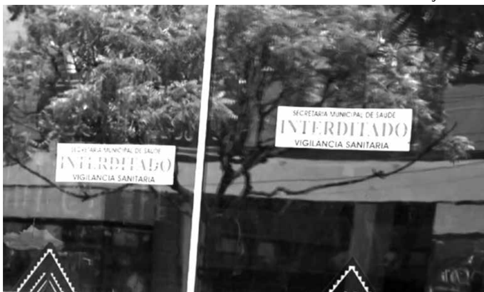
Estabelecimento não possuía autorização do Corpo de Bombeiros para funcionar
