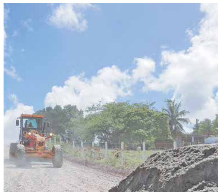
Obras de terraplenagem preparam pavimentação e avenida
