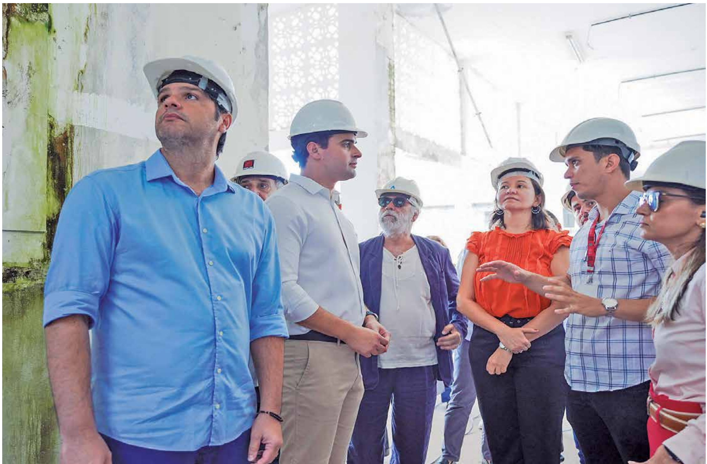
O governador em exercício Lucas Ribeiro (camisa branca) recebe explicações de técnicos sobre o andamento das obras que estão sendo realizadas no Parque Tecnológico Horizontes de Inovação
