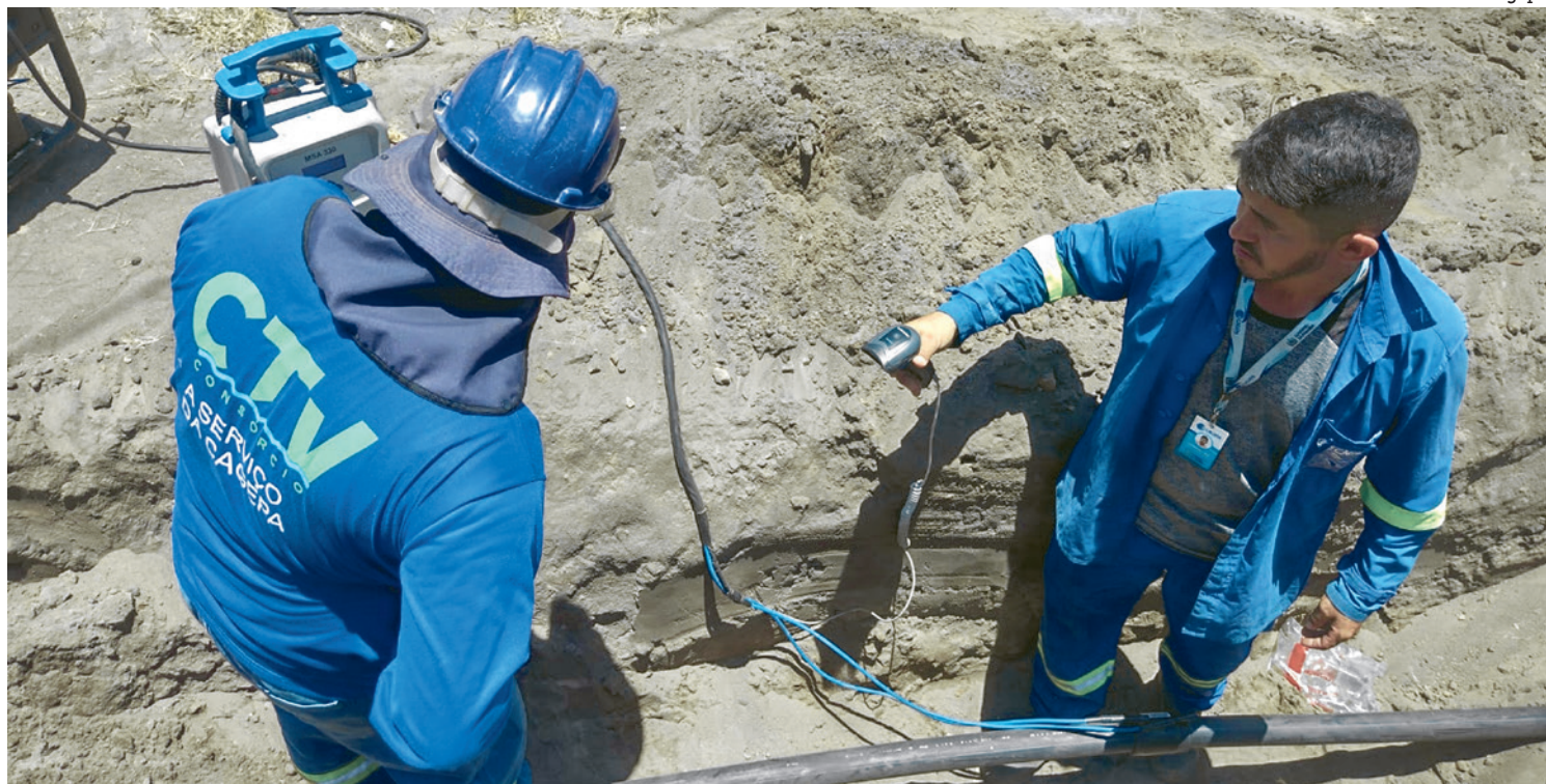
Obras incluem expansão da rede de abastecimento no Loteamento Village Jacumã, que já conta com 50% do trabalho concluído
