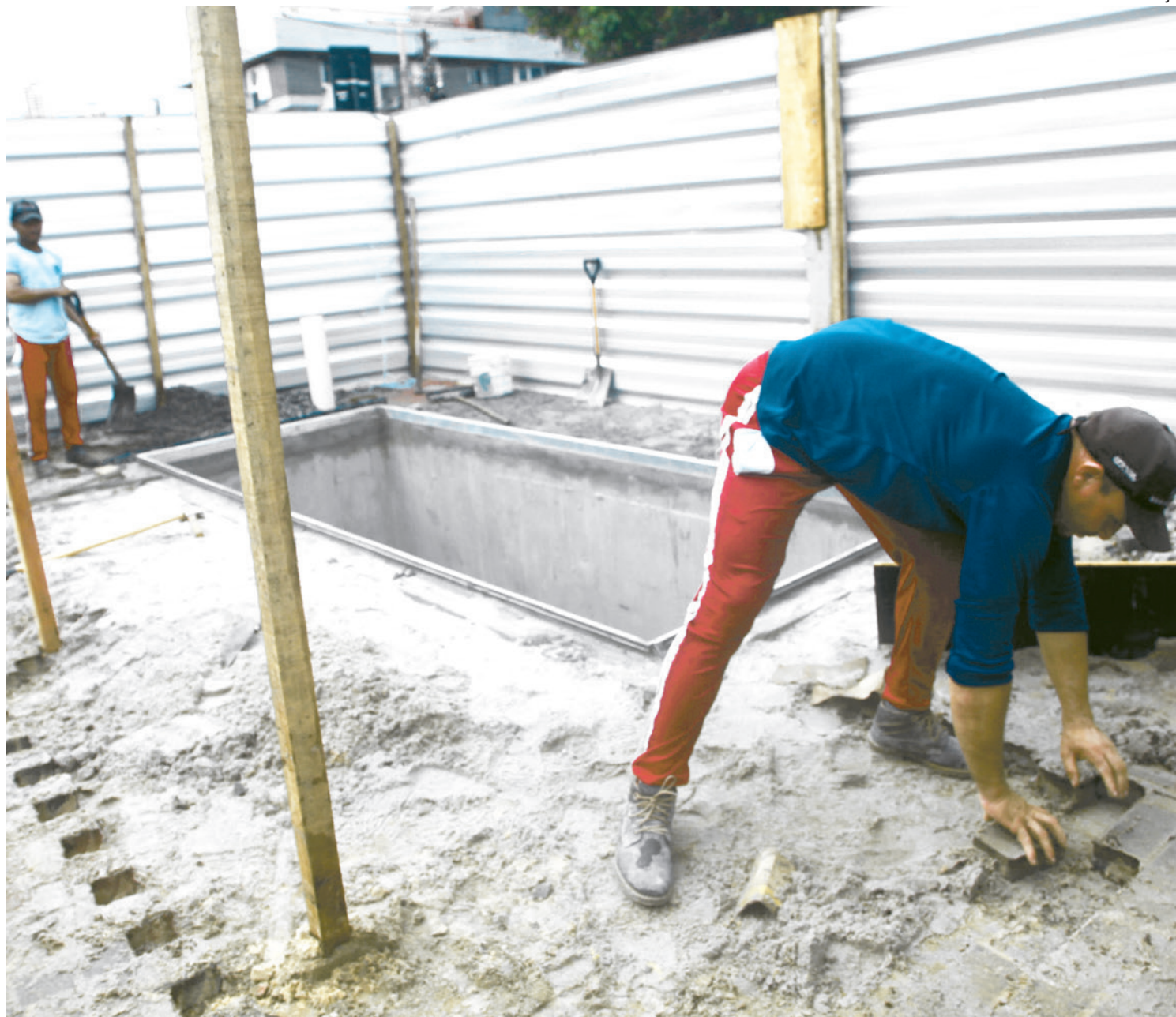
Método impede que as pessoas sintam odores advindos dos resíduos sólidos descartados. Sistema ainda permite drenagem da água da chuva
