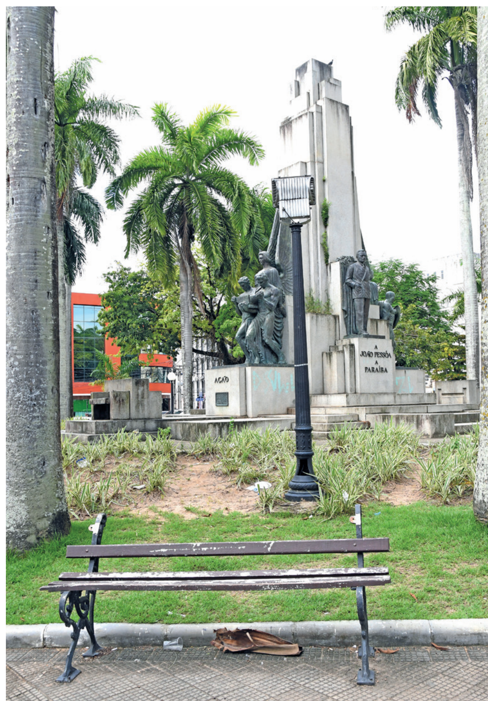
Na Praça João Pessoa, bancos, monumentos e canteiros de plantas demandam manutenção
