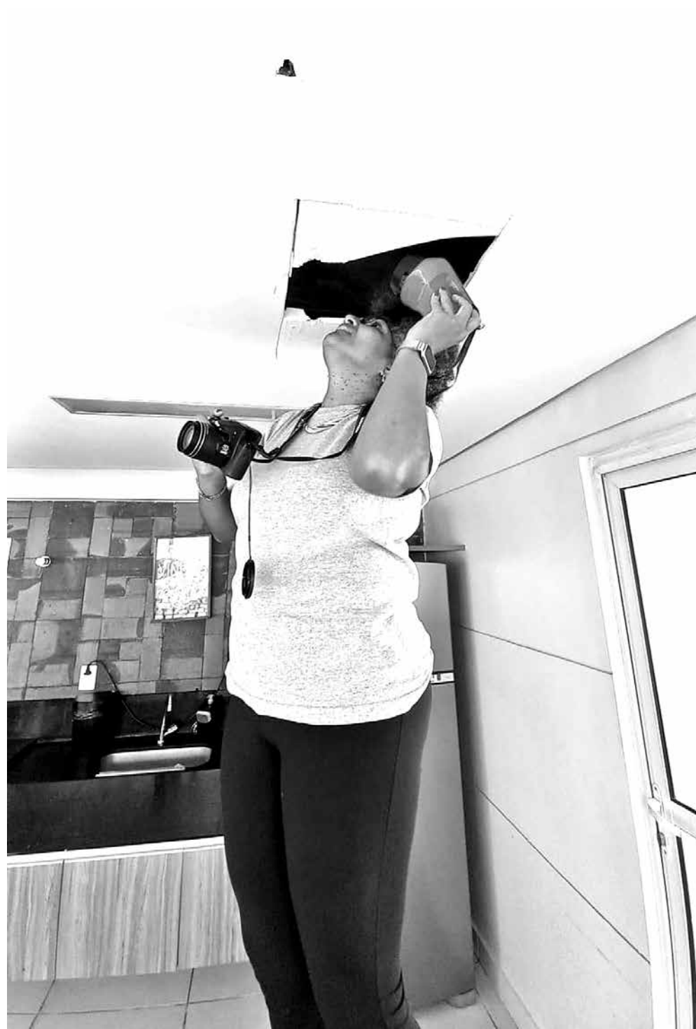
Suenne Barros cita fissuras e rachaduras como alguns dos problemas detectados nos prédios
