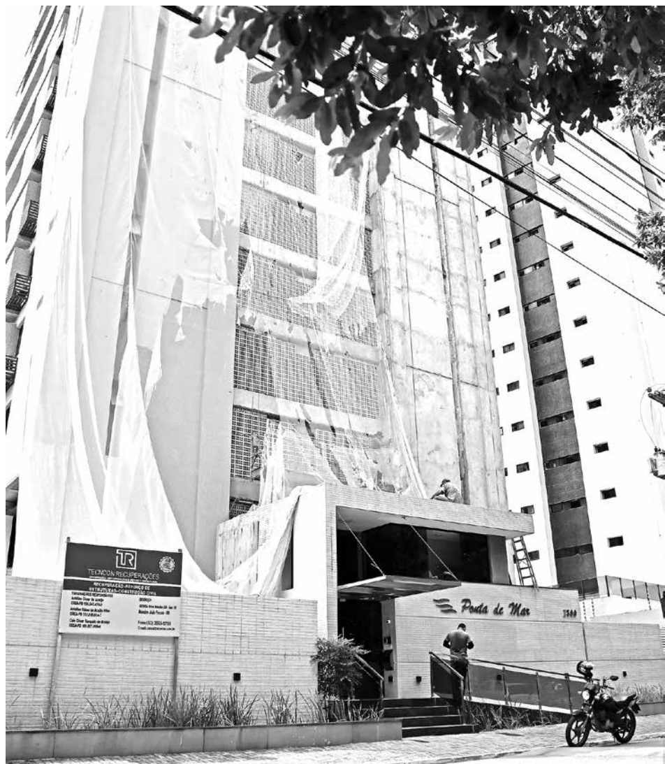
Edifício Ponta de Mar, em Manaíra, está trocando revestimento da fachada
