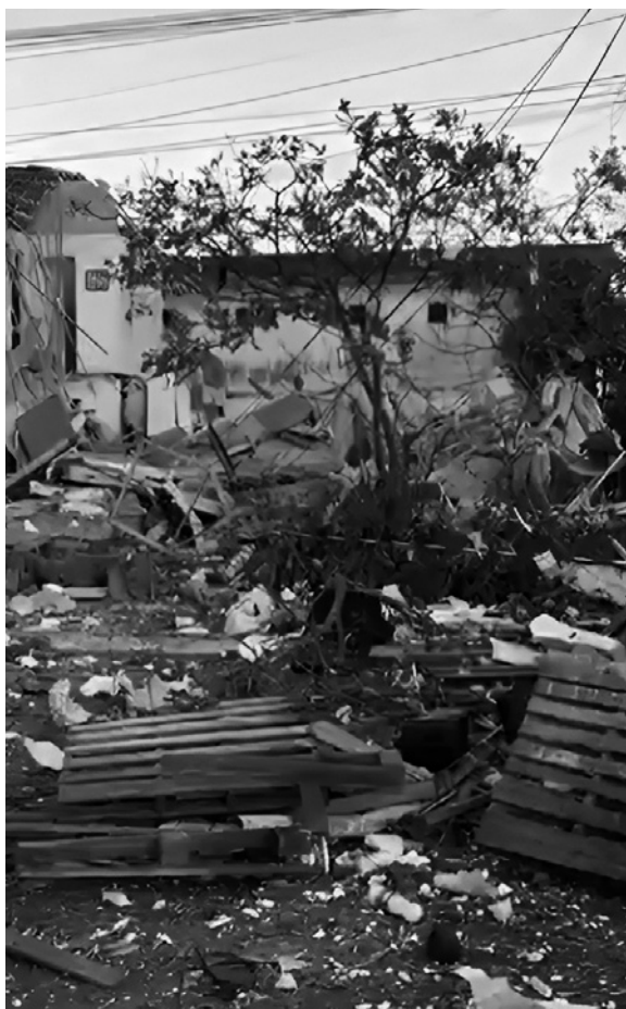
Causas do acidente ainda estão sendo investigadas
