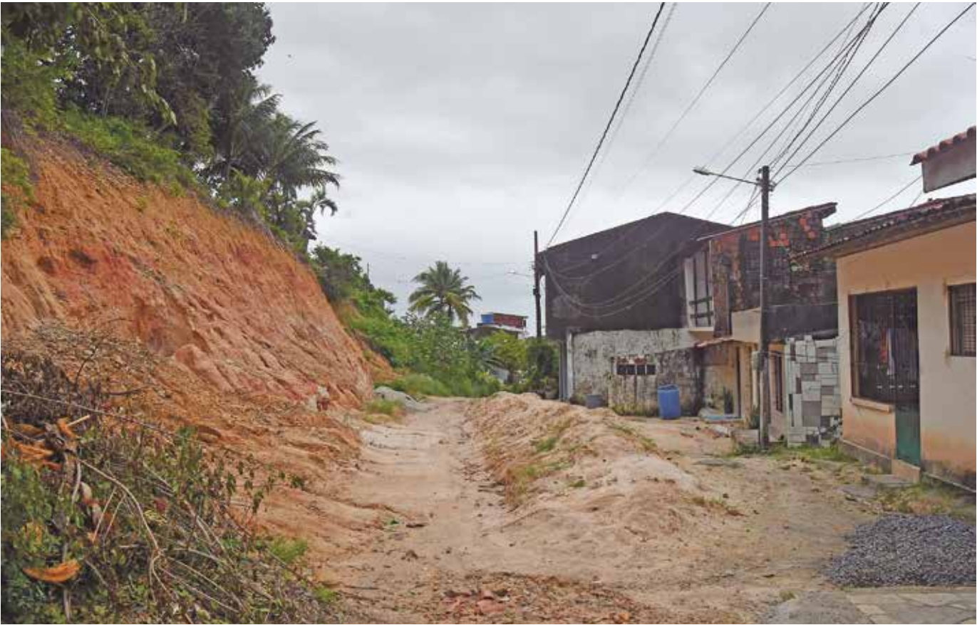
Os desgastes erosivos acontecem também em zonas residenciais, colocando em risco as pessoas que moram próximo
