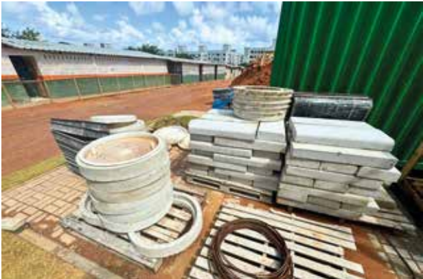
Concreto excedente é transformado em peças pré-moldadas
