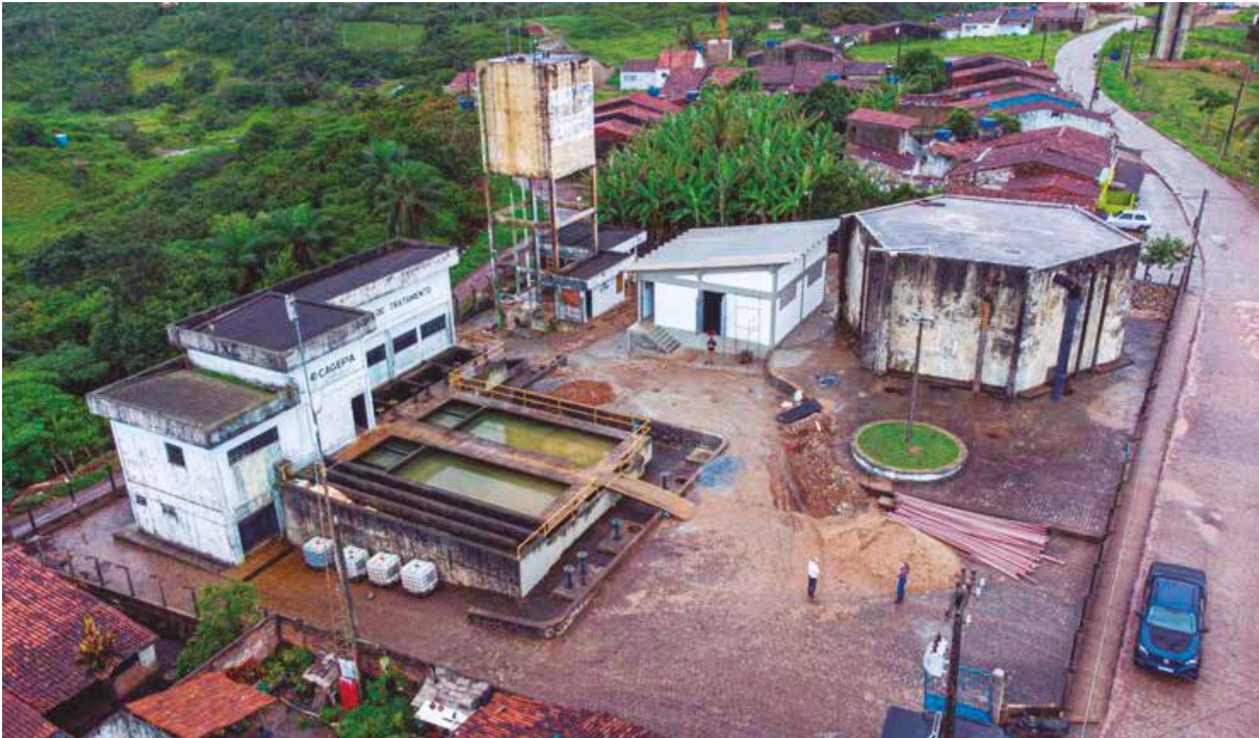
A adutora de Nova Camará, localizada na cidade de Alagoa Nova, foi a principal responsável pela distribuição, por meio das operações do seu ramal 2
