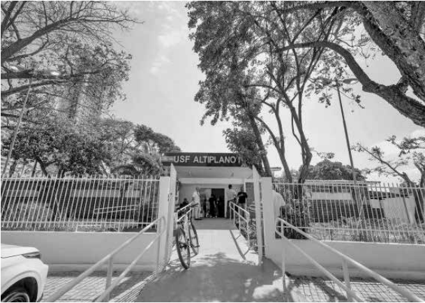
Fachada ganhou um revestimento cerâmico novo
