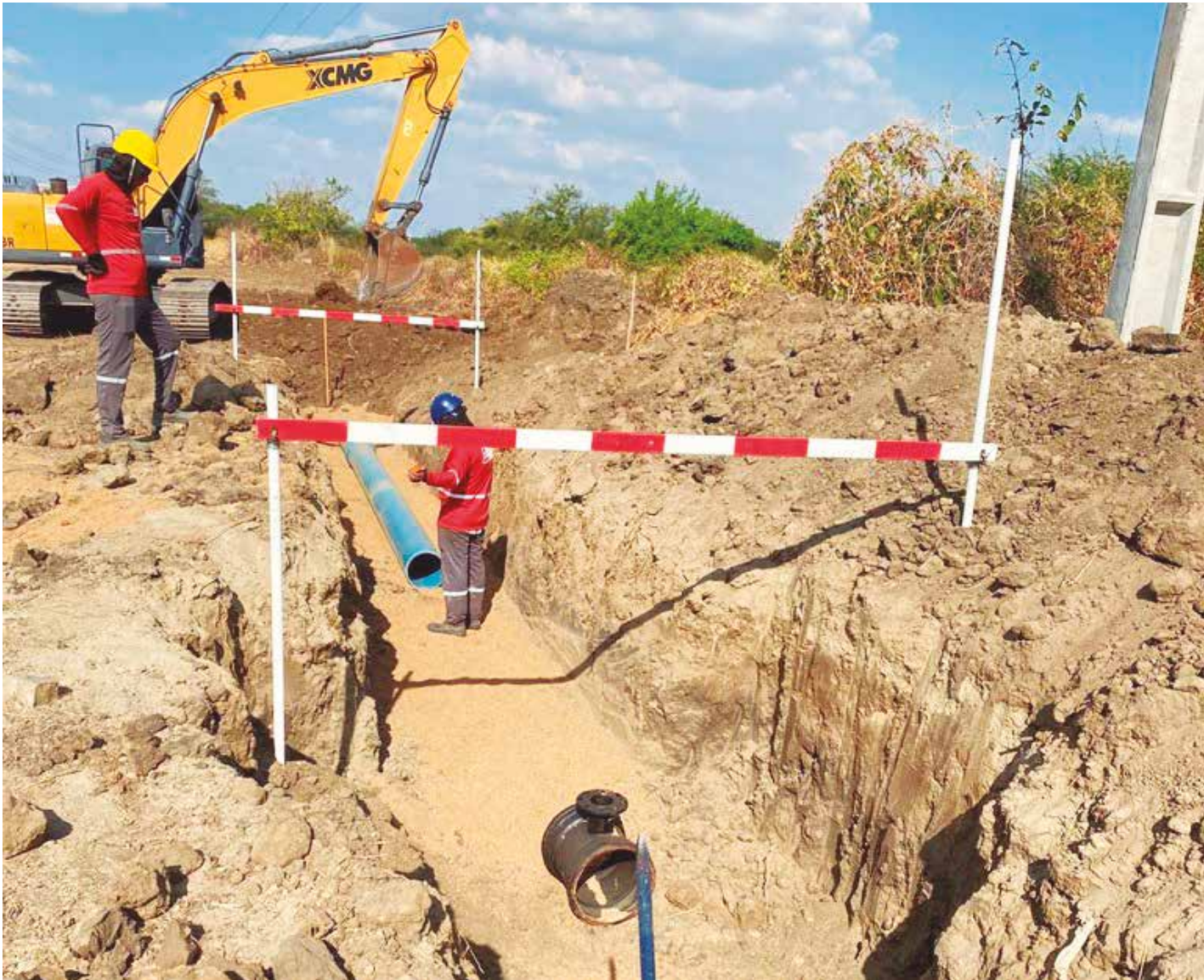
A construção da subadutora da Zona Oeste é considerada estratégica para a distribuição de água em toda a cidade
