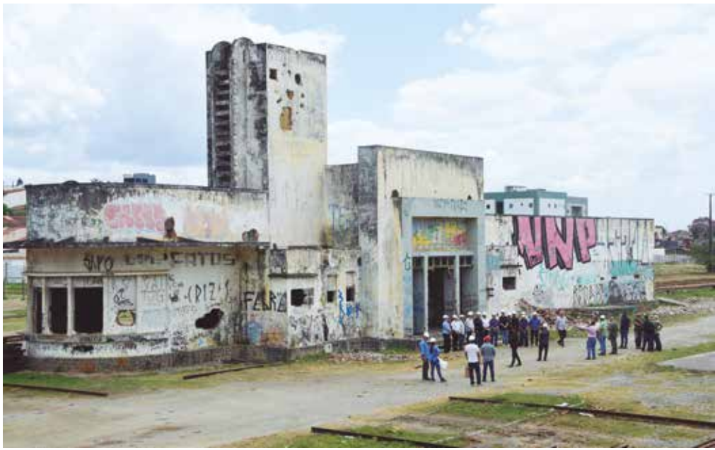
Também foi discutido, durante a reunião, o prazo para a conclusão das obras na Estação Nova
