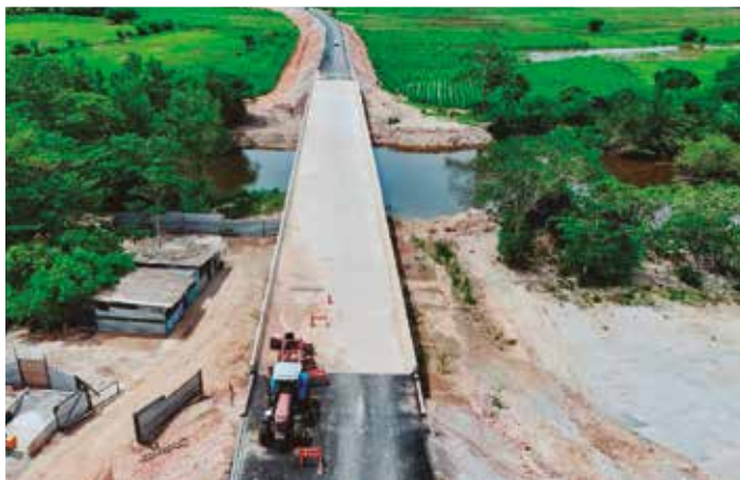
Projeto em execução na PB-033 prevê construção de duas pontes
