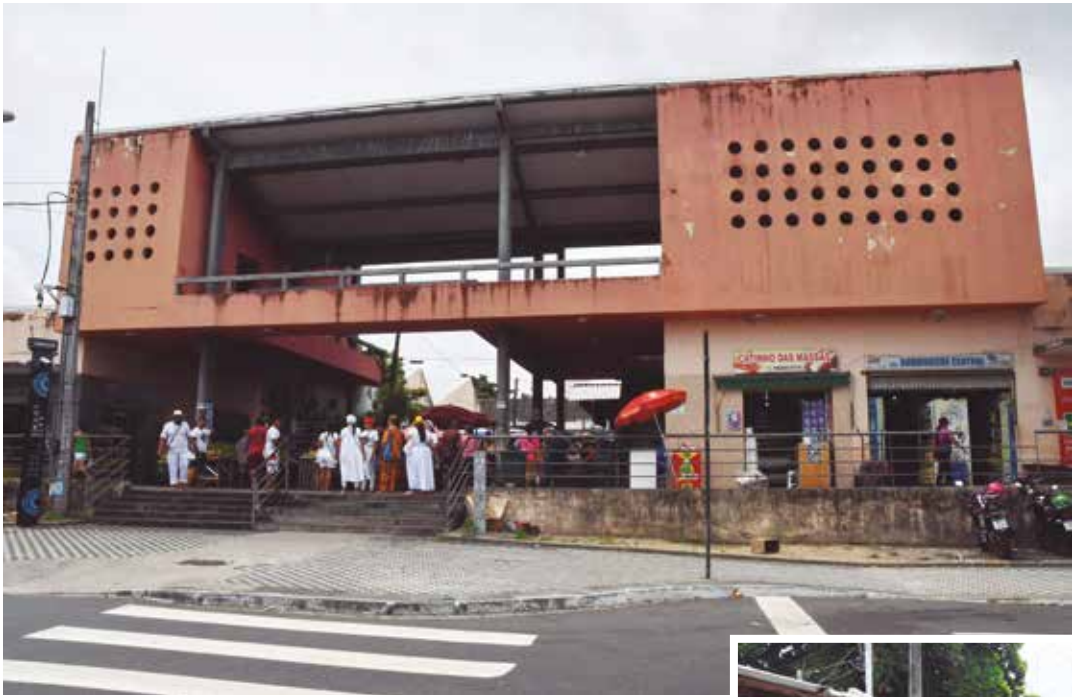
Na área mais distante da fachada, localizada em paralelo à Avenida Marechal Almeida, será iniciado o trabalho; lá está prevista a construção de um estacionamento
