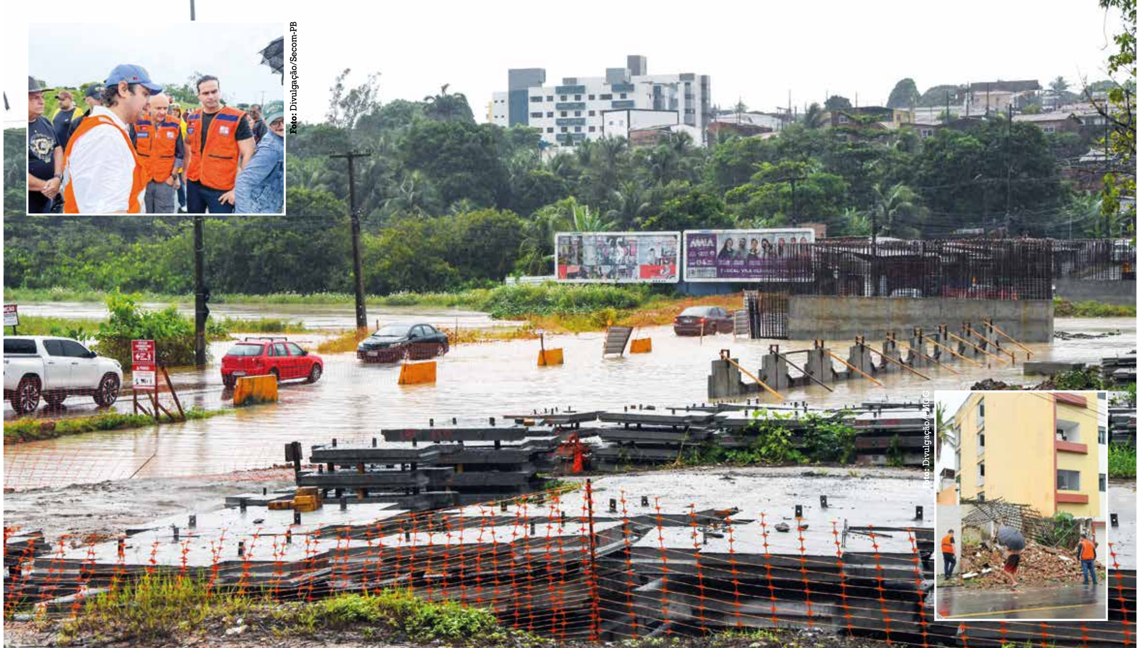
Rio Cuiá transborda sobre ponte, em JP; Lucas Ribeiro inspeciona áreas alagadas (no detalhe, acima); em CG, casa abandonada vai ao chão (detalhe inferior)
