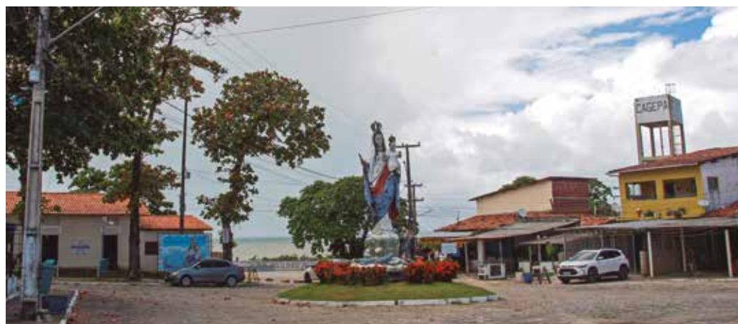
Projeto inicial inclui a construção de lojas, banheiros acessíveis e uma calçada de passeio
