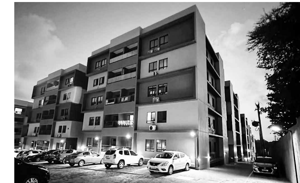
Elevadores do Altiplano Reserve I e do Altiplano Reseve II foram interditados pela Defesa Civil
