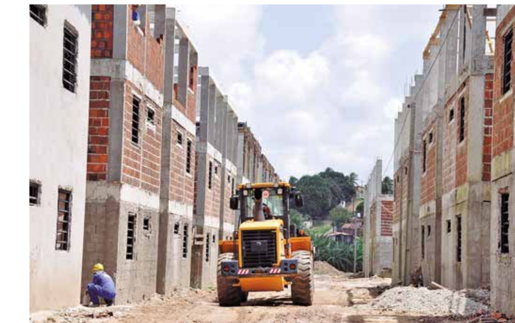
Atualmente, a capital paraibana conta com 14 empreendimentos aprovados pela Caixa
