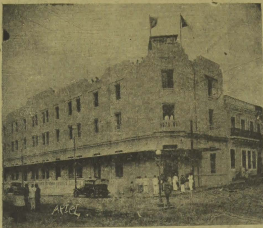
Fachada do "Parahyba Hotel"
