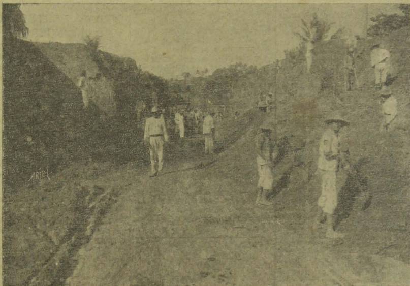
Outro aspecto da rodovia João Pessôa a Goyana. (Serviço de alargamento do côrte n.º 1)
