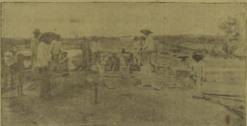
Construção de um pontão na rodagem Patos-Misericordia
