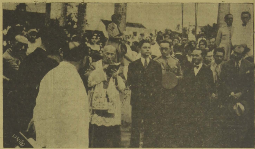
Aspecto apanhado quando o exmo. sr. arcebispo D. Aduaco abençoava a primeira pedra, vendo-se á sua esquerda o sr. interventor Gratuliano Brito.
