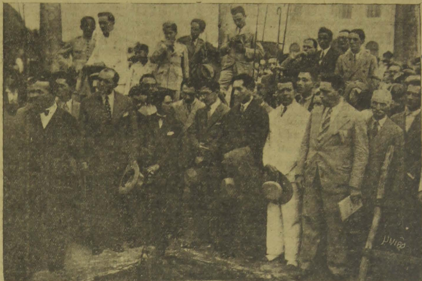
Autoridades estaduais, federaes e municipaes assistindo á collocação da pedra fundamental.
