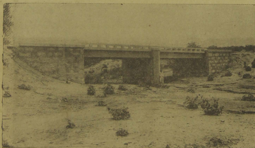
Ponte na estrada tronco, sobre o rio Solitude
