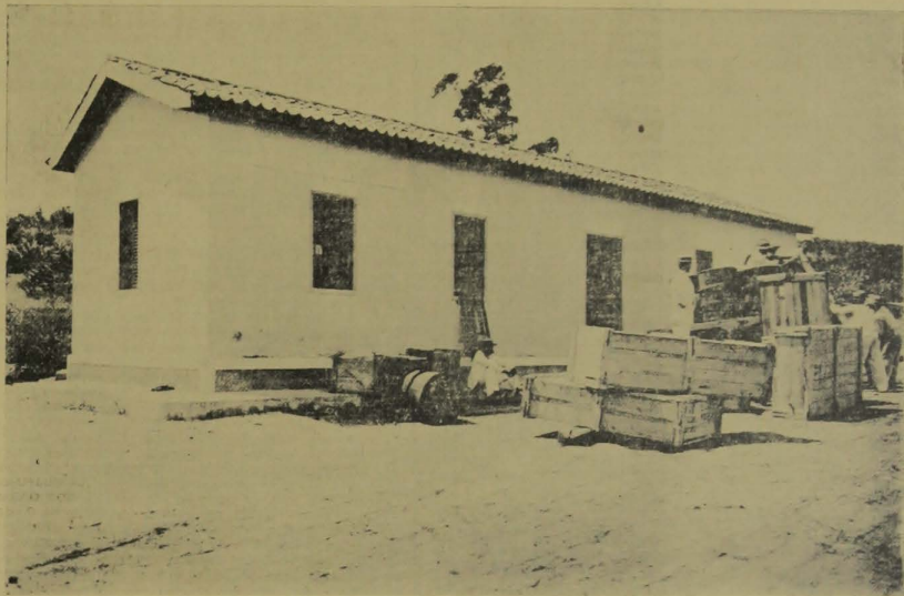
Pavilhão recentemente construído na sede do Instituto Serico do Estado, onde está sendo instalada a Secção de Fição, anexa à Escola de Sericultura, vindo-se, no clichê, o descarrego das maquinas recentemente adquiridas pelo governo estadual.
