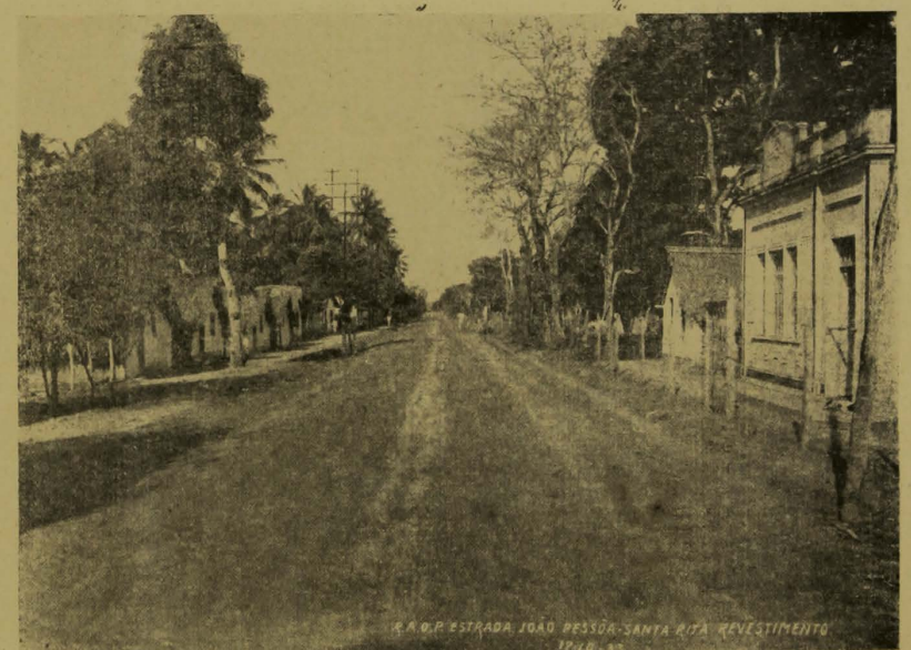
R. A. O. P. — ESTRADA JOÃO PESSOA-SANTA RITA — Trabalhos de revestimentos executados.
