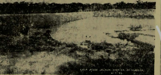
Acude "Lagã das Barainas", em Cajazeiras, um dos cinco construídos em 1933, custado pela Caixa Estadual de Obras Contra os Efeitos das Secas.
