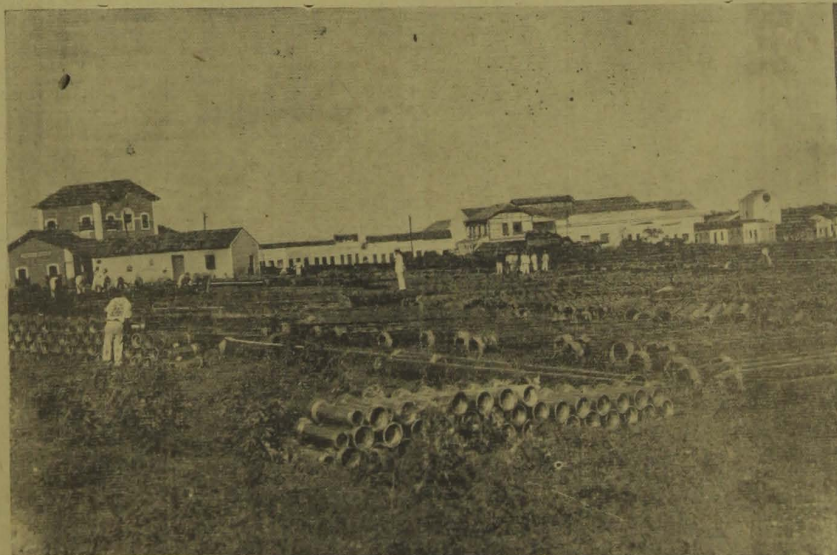
Tubos de ferro fundido, com cintas de aço, para o serviço de encanamento, em deposito perto da cidade de Campina Grande.
