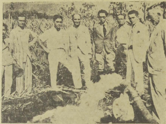
Bomba de três polegadas, em Catolé do Rocha, na fazenda "Olho d'Água", do sr. Sergio Maia. Esta agua tornou possível bellissimo cannavial, em pleno verão sertanejo.
