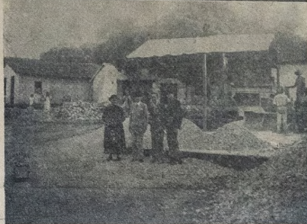
Aspecto da visita do dr. Raul de Góis, secretário interino da Agricultura, Viação e Obras Públicas, ao local onde vão ser brevemente iniciados os serviços de pavimentação, a concreto, da estrada Cabedêlo-Campina Grande, no trecho João Pessoa-Santa Rita. Vem-se ainda o dr. Otavio Pernambuco, diretor de Obras Públicas, conego José Coutinho, diretor do Serviço de Assistência Social, e jornalista Lopes Gondim, encarregado de publicidade da Secretaria da Agricultura.
