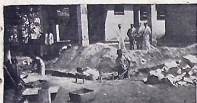
Construção de um dos pavilhões
