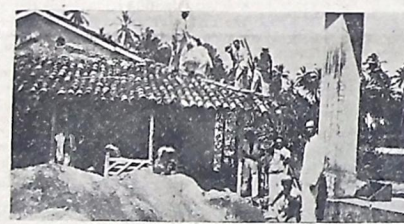
Outro aspecto dos trabalhos
