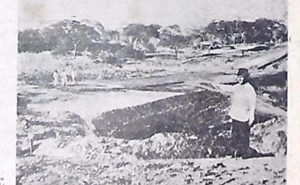
Construção do acúde da firma Baracul, Loureiro & Cia. No primeiro plano, vê-se o sr. Brasilino Loureiro, sócio da empresa.
