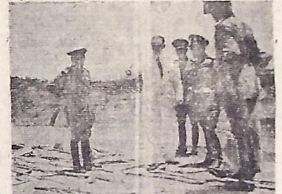
O interventor Ruy Carneiro e o general Souza Ferreira em visita aos trabalhos de reconstrução da estrada de Cabedelo
