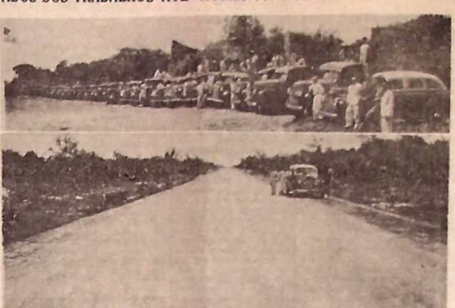
1 - Frota de veículos empregados no serviço de terraplanagem. - 2 - Trecho da estrada já revestida
