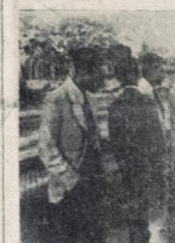
O DIA DE ONTEM DO SR. INTERVENTOR FEDERAL: — Foto do Sr. Interventor Federal mostrando ao governador Francisco Penabaz a detalhes da estrada João Pessoa-Cabedelo. (Texto na 3.ª página)
