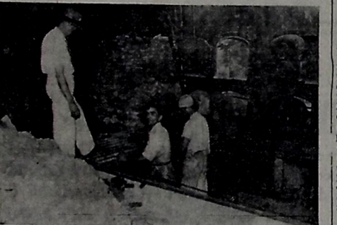
Reforma do cinzeiro da caldeira numero 3 para maior eficiência do serviço.
