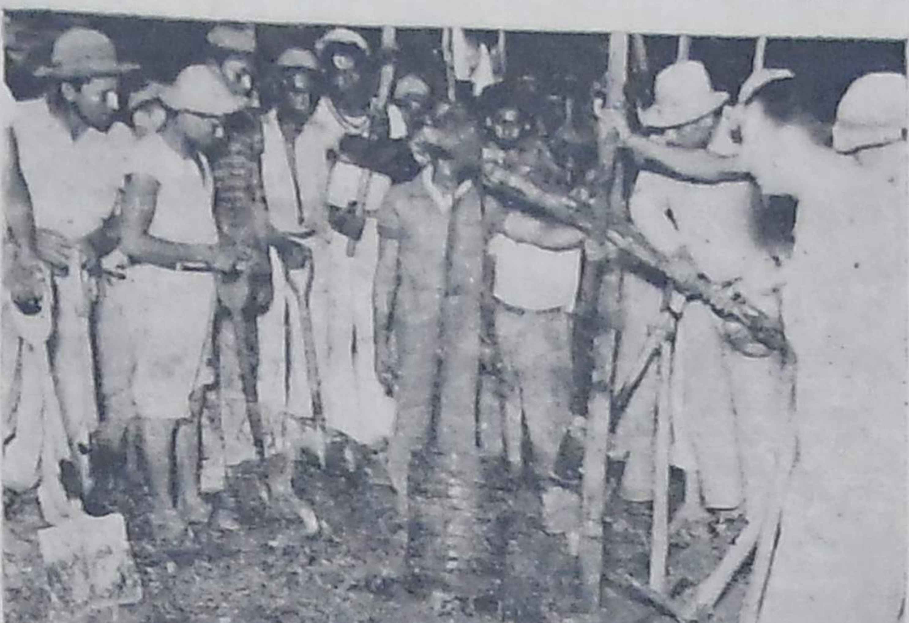
A bomba localizada e removida pelo S. de Desobstrução e Incendios, no exercicio de ontem
